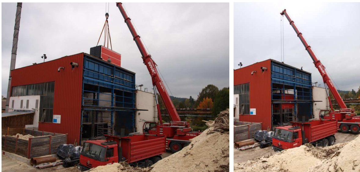
Obrázok č.5 – Vďaka menším rozmerom a nižšej hmotnosti dánskeho biomarového kotla o výkone 4,0 MW, bolo možné osadiť technológiu do priestorov rekonštruovanej kotolne pomocou mobilného žeriava cez strešnú časť oceľovej konštrukcie.
