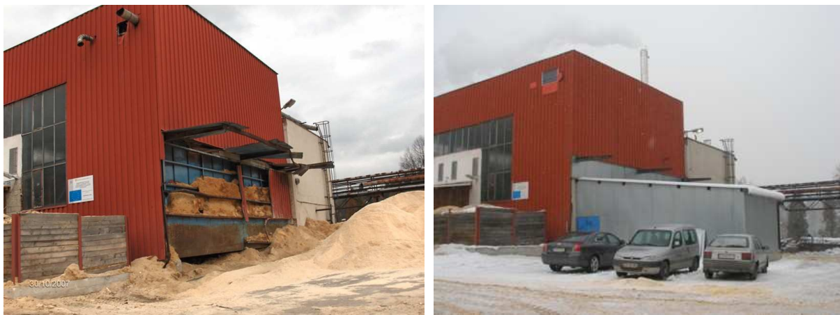
Obrázok č.1 – Pohľad na biomasovú kotolňu s inštalovaným výkonom 3,5 MW pred realizáciou projektu a po realizácii
